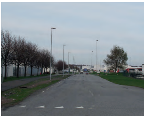
Terminalvägen mot norr i korsningen med Arendals Allé, cykelbanan ligger utefter den västra sidan
