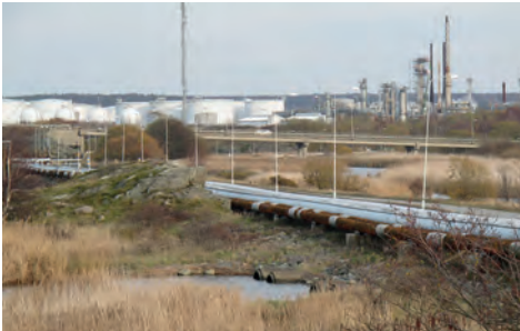
Preemraff sett från Hjärtholmsvägen. Väg och ledningar är förlagda på smala landtungor mellan de olika dammarna.
