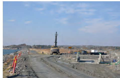
Sluttäckning av mudderdeponin
