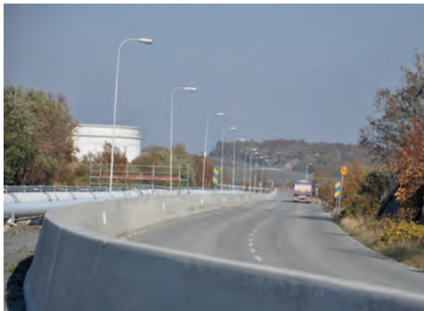
Hjärtholmsvägen med ledningar
